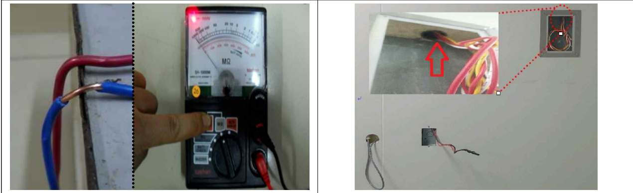
전선의 이상유무 확인 → 절연저항 측정
